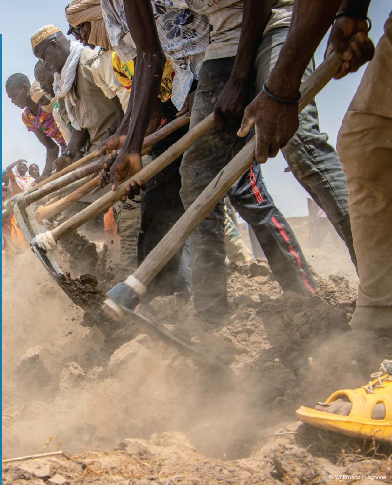
西アフリカ マリのトンブクトゥ近郊のコミュニティで、洪水に見舞われた後、再び稲作ができるよう堤防を修復しています。
